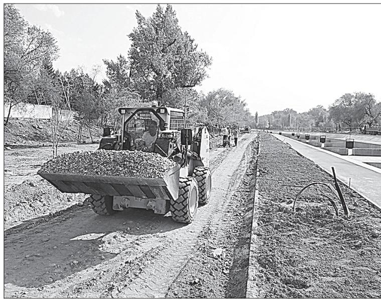
Он также ответил на вопросы по поводу качества поребриков и при асфальтировании, как сделал замечание технадзор — новые поребрики повреждены при укладке асфальта неделю назад. К слову, проектом предусмотрены две дорожки — одна для пешеходов, вторая для персонала.
